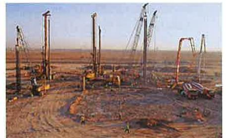
Für die langen Pfähle wurden zwei modifizierte, eigens für lange Kellys eingerichtete Bohrgeräte eingesetzt.
